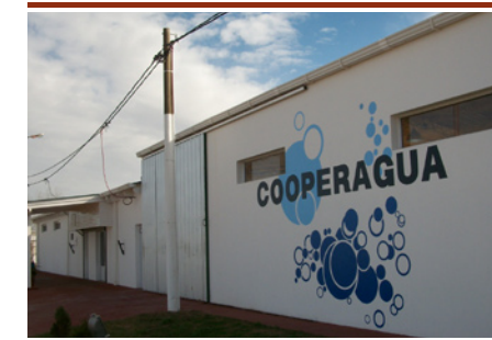
Planta de agua envasada
