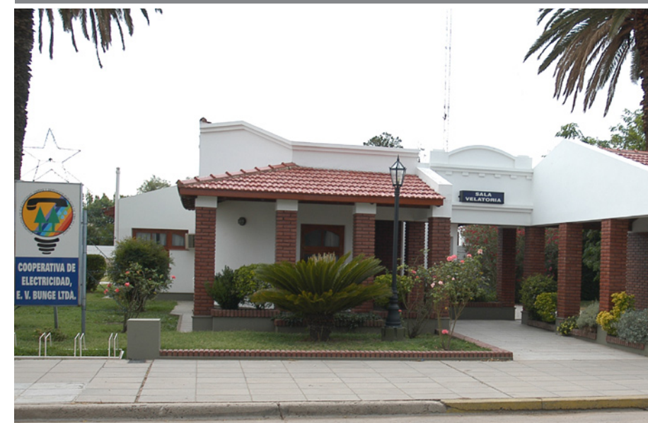
Frente de la sala velatoria sobre calle Europa.
