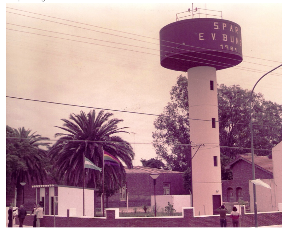
Tanque de agua corriente e instalaciones
