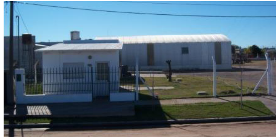
Actual oficina y depósito del sector de Energía
